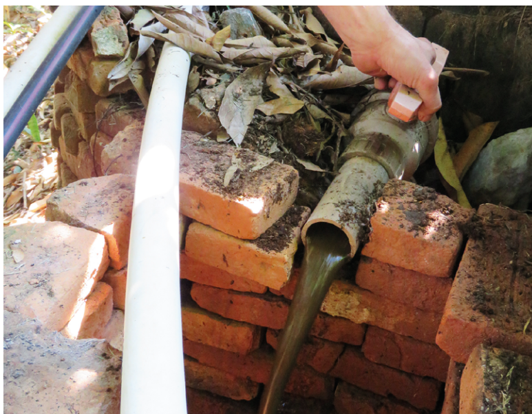
FIGURA 47. Remoção de lodo por diferença de pressão hidrostática em tecnologia comercial (Foto: Isabel Figueiredo).
