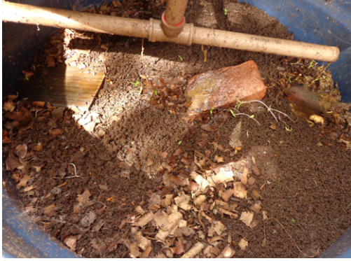
FIGURA 2. Detalhe de um vermifiltro unifamiliar com recheio de serragem. É possível observar a camada de vermicomposto (húmus) (Foto: Isabel Figueiredo).
