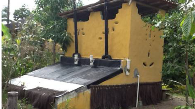
FIGURA 2. Banheiro seco construído em duplicidade em Itacaré, BA. A foto mostra a tubulação de ventilação e a câmara de compostagem (Foto: Isabel Figueiredo).
