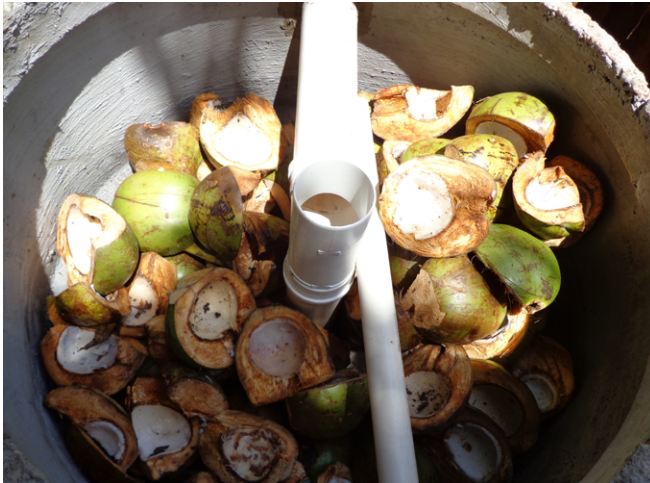
FIGURA 3. Casca de coco utilizada como meio suporte no filtro anaeróbio. Campinas- SP (Foto: Isabel Figueiredo).
