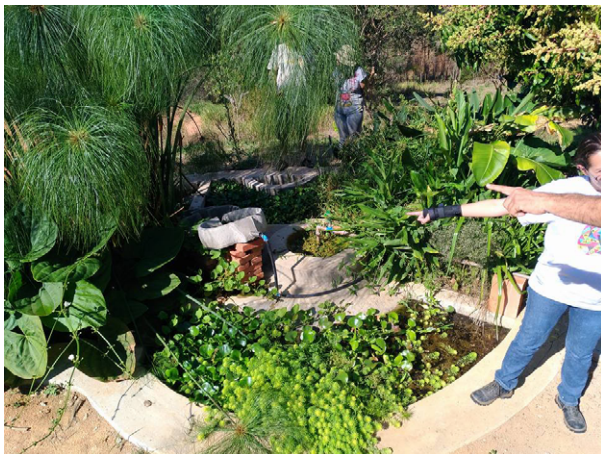
FIGURA 3. BSI unifamiliar no Espaço Almagestum, Pedra Bela-SP. O filtro anaeróbio e zona de raízes foram construídos sobre o biodigestor. No centro, o encanamento para saída do biogás (Projeto: Guilherme Castagna. Foto: Isaías Reis).
