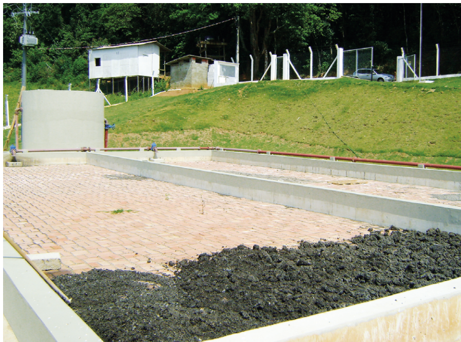
FIGURA 44A. Leito de secagem sem cobertura. Vista geral dos leitos (Foto: Kayo Wachholz).
