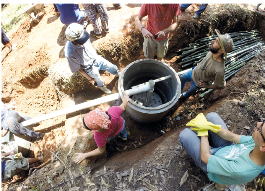
FIGURA 9B. Mutirão de construção de tanque séptico e filtro anaeróbio de coco (Foto: Pedro Savastano).
