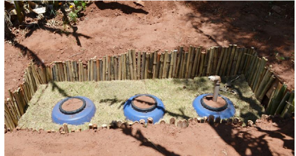
FIGURA 5. Fossa séptica econômica implantada em área rural de Pederneiras-SP (Fonte: Postigo et al., 2017).
