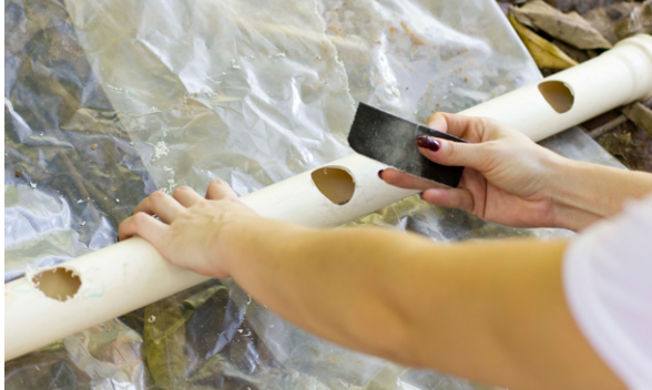
FIGURA 2. Tubo de PVC 50mm perfurado para distribuição do esgoto (Foto: Pedro Savastano).
