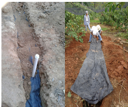
FIGURA 5. Material filtrante coberto com manta tipo bidim (no detalhe, o respiro e o reaterro) e lona plástica perfurada. Campinas-SP (Foto: Isabel Figueiredo).
