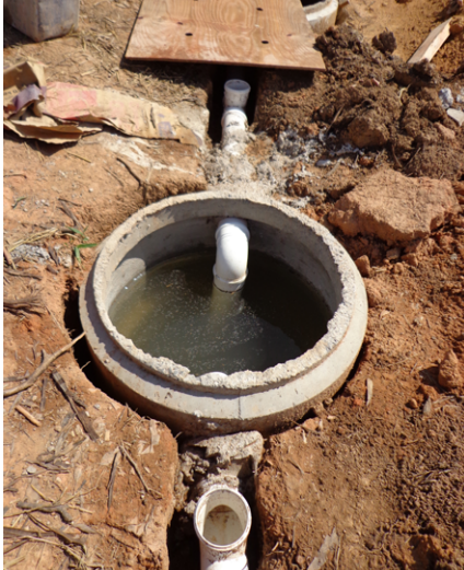
FIGURA 2. Tanque séptico (ainda sem a tampa instalada), construído em anéis de concreto. Campinas-SP (Foto: Isabel Figueiredo).
