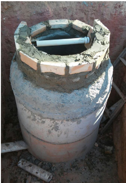
FIGURA 4. Biodigestor de anéis de concreto. Na imagem a cúpula está sendo construída com tijolos e suportará a tampa. A tubulação de PVC que chega na base é a entrada de esgoto (Foto e projeto: Guilherme Castagna).
