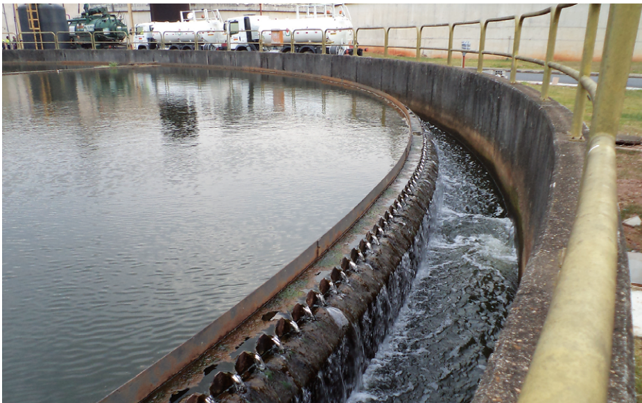
FIGURA 14. Esgoto tratado em ETE, em conformidade para ser lançado em corpo hídrico (Foto: Adriano L. Tonetti).
