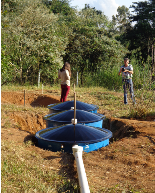
FIGURA 2. FSB instalada em Holambra-SP. As caixas de fibra tiveram suas tampas pintadas de preto (Foto: Isabel Figueiredo).
