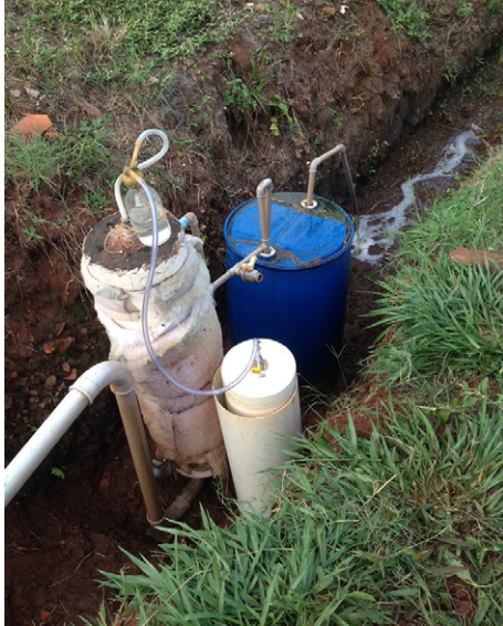
FIGURA 2. RAFA unifamiliar implantado em área rural. Este protótipo simplificado e de baixo custo encontra-se em fase de estudo em Botucatu-SP. Ele é confeccionado com tubo PVC 300mm (Foto: Guilherme Franceschini).
