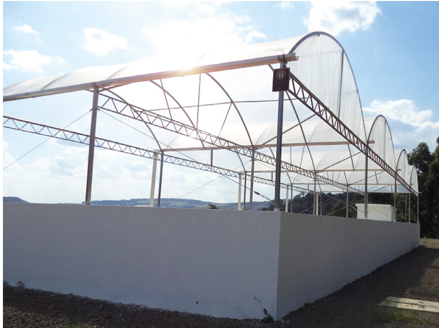
FIGURA 43. Leito de secagem de lodo proveniente de sistema semicoletivo, com cobertura de telhas metálicas (Foto: Kayo Wachholz).
