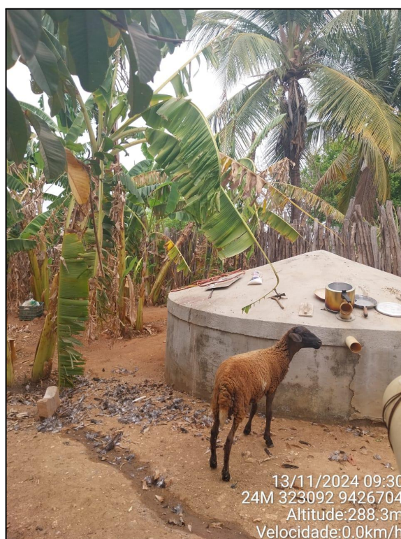
Figura 19 - Presença de vegetação no entorno das cisternas
