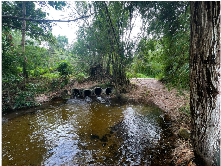
Figura 25. Imagem da chegada do Rio Acuba na Vila de Santo André, entre o Campinho e a pista (exutório).
