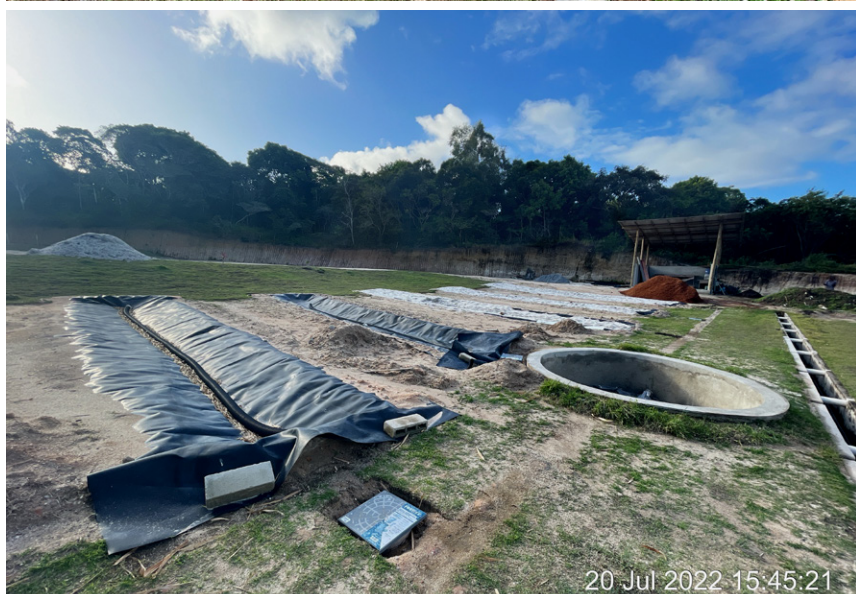
Figura 35. (acima) Acondicionamento inadequado de resíduos de grandes geradores em local de mata próximo à Santo Antônio. O resíduo foi depositado pela própria Prefeitura Municipal. Figura 36. (abaixo) Pátio Escola.
