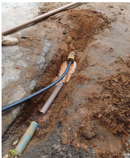
Figura 13. Exemplo de operação de limpeza da tubulação de água.
