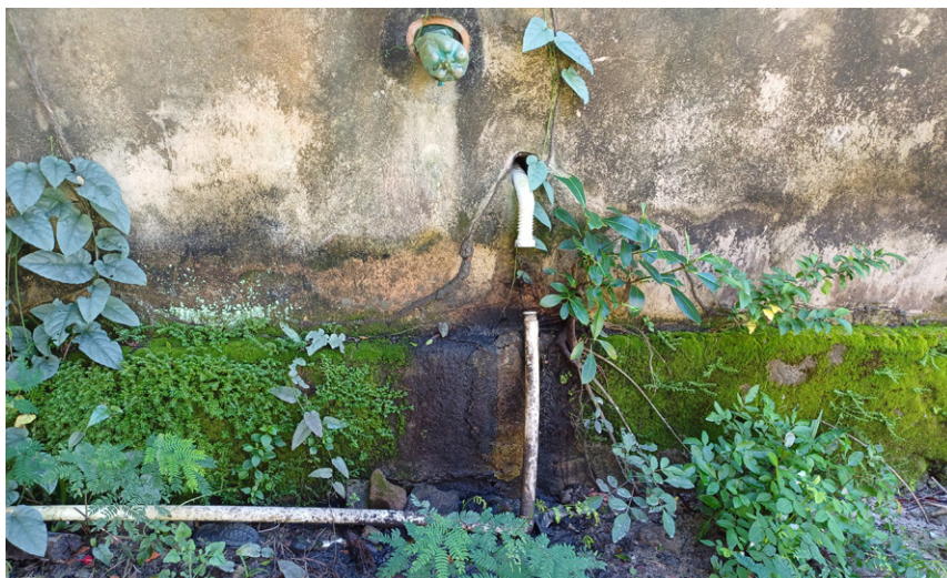
Figura 17. Água cinza da cozinha indo direto para o solo, sem tratamento.
