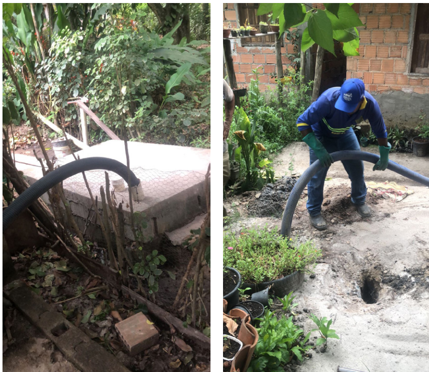
Figura 21. Serviço de limpa-fossa em Santo André.
