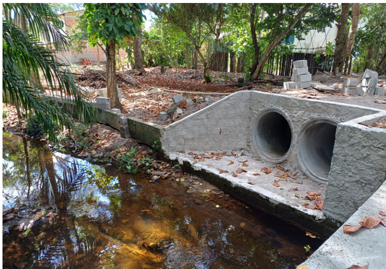
Figura 26. Galeria Pluvial reformada pela Prefeitura Municipal, com apoio técnico do SANEA Santo André.
